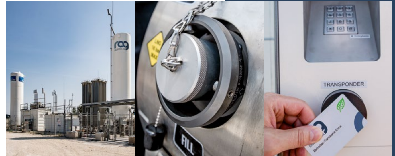
In einer Pilotanlage in Puchkirchen/OÖ wird bereits LNG hergestellt.
